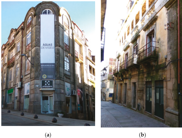
Figure 6. Águas de Viseu : (a) view to Rua do Comércio; and (b) view to Rua D. Duarte.
