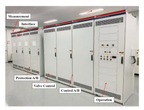
Figure 5. TCSC actual controller on-site.
