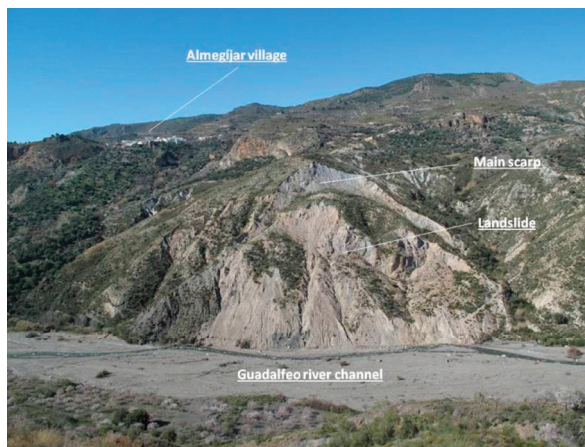
Figure 2. The Almegijar landslide.
