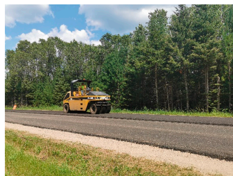
(d) Compaction of the CIR layer
