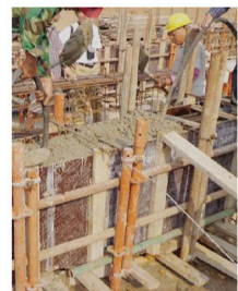
(d) Concrete casting
