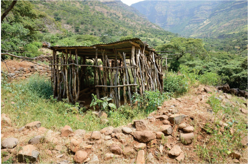
Figure 11. The Şəbra synagogue at Səmen Mənaşa. In the background: the ravine in which the springs of Wəsta Şəgəy are located.
