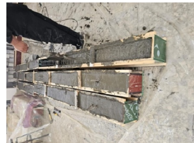
(b) Pouring concrete
