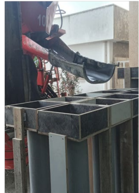
(d) Pouring of the concrete
